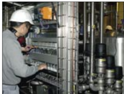
Kontrol af IO-tavleanlæg i produktionen
