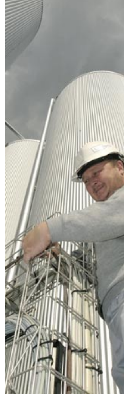
Færdiggørelse af udendørs installationer
